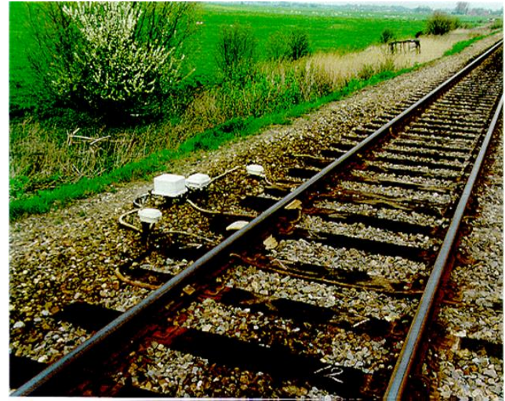
Gn-Swd 2002 GRS-spoorstroomloopen, pedaal S44, Wielsensor, massadetectielus
